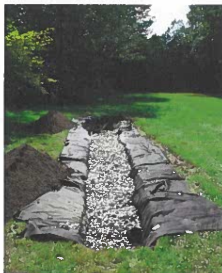
Figure 1 : Exemple de tranchée d'infiltration
